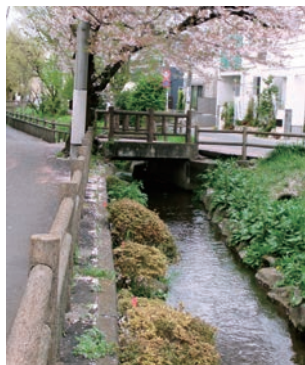
東北浦橋の上流方向
