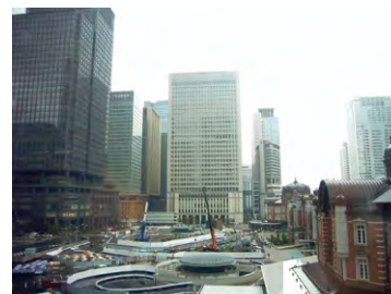
④まだまだ工事の進む丸ビル周辺
